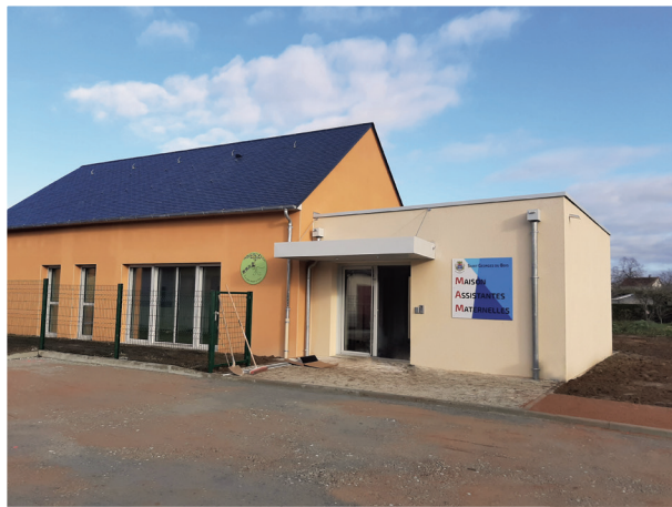
Photos de la M.A.M en cours de travaux
